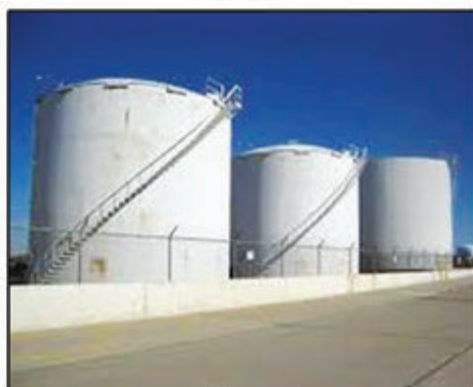
ถังเก็บน้ำมันบนดิน
