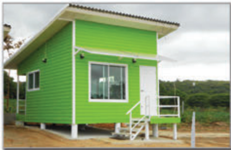
บ้านประกอบเสร็จ
