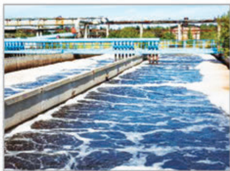
บ่อบำบัดน้ำเสีย
